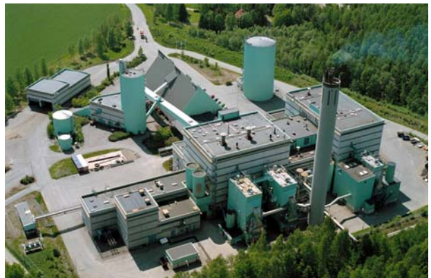
Karlskoga värmekraftverk, en av anläggningarna som eldar Biomal
